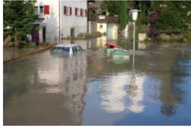
Überflutungen bringen in der Regel Kontamination und Ausfall der Wasserversorgung mit sich (Bild: Göfis/V)
